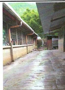
Foto 6: COLOCACIÓN DE LOSA DE CONCRETO PRENTE A AULAS DE LA PARTE DE ATRÁS DEL ESTABLECIMIENTO
