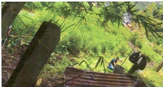
Foto 1: LIMPIEZA Y MEDICIÓN DEL ÁREA DE MURO DE CONTENCIÓN
