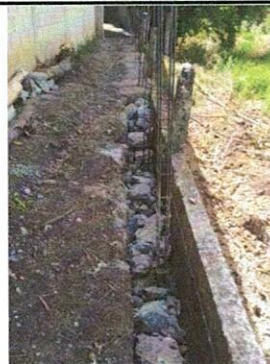
Foto 2: FUNDICIÓN DE LA BASE DE MURO PERIMETRAL EN RIESGO
