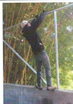
Foto 4: COLOCACIÓN DE MALLA EN MURO PEROMETRAL
